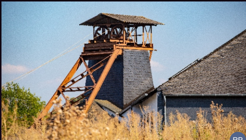
RP Ehemaliges Dachschieferbergwerk Margareta Rheinland-Pfalz, Nettelsrusch, Lkr. Mayen-Koblenz Foto: R. Lang
